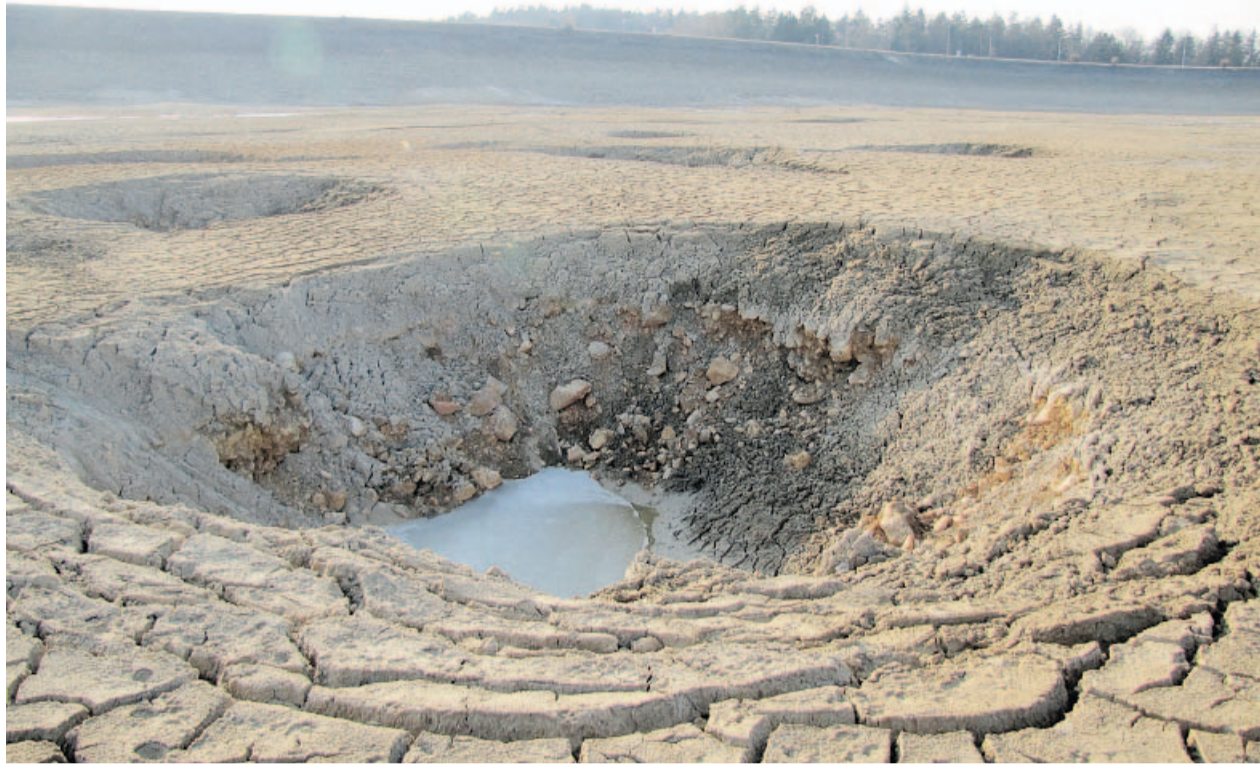
Der Happurger Wasserspeicher im Nürnberger Land sieht wie eine Kraterlandschaft aus.
